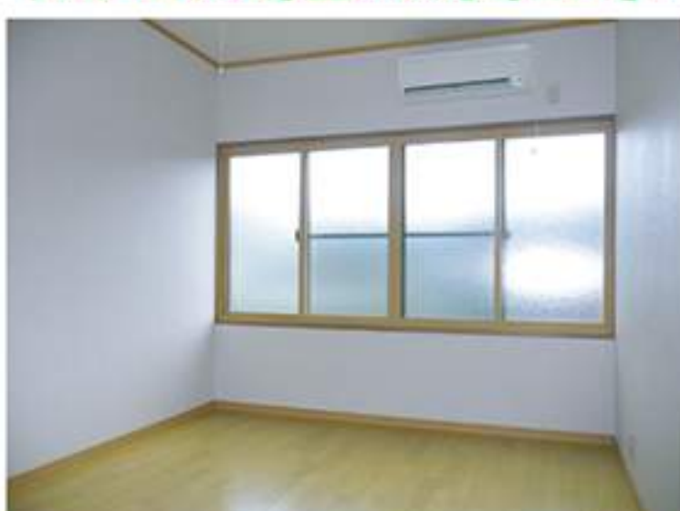
窓の断熱改修 ex.インフラの取付
