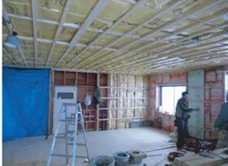
外壁・天井等の断熱改修
